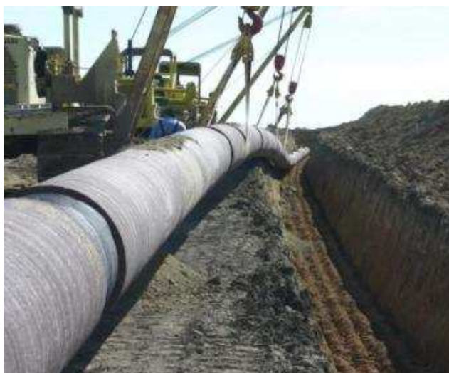
Фигура 3.14 Спускане на тръбата в траншеята
