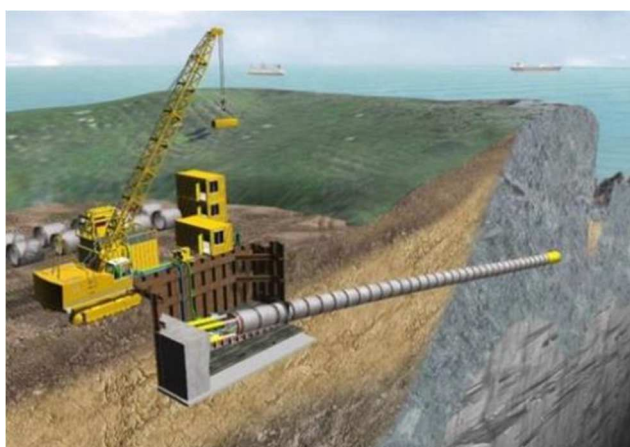
Фигура 3.11 Типично строителство на микротунел
