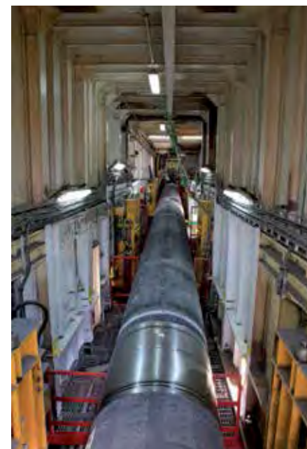
Тръбите се свързват и инспектират на борда на кораб за полагане на тръби. - снимката е предоставена от „Северен поток“ АГ
